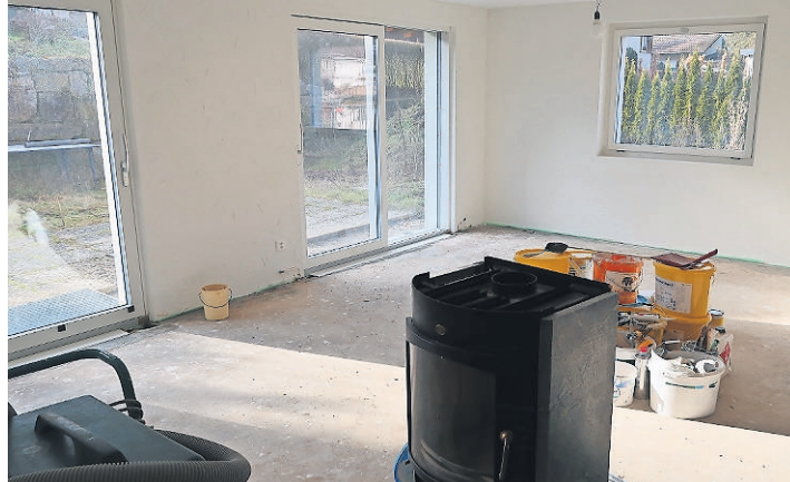
Im Erdgeschoss des Hauses soll ein Aufenthaltsraum entstehen.
