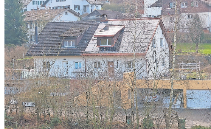
Die Schule wird sich in der rechten Hälfte dieses Hauses befinden.
